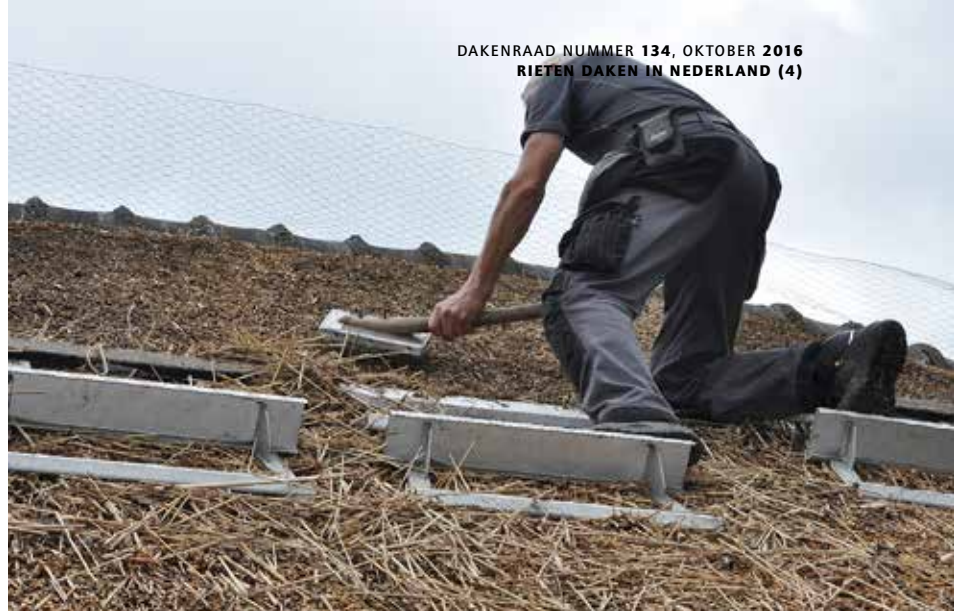
Na het opstoppen wordt het geschoonde en nieuwe riet aangedreven.
